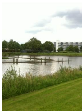
▲ Bassin en eau
