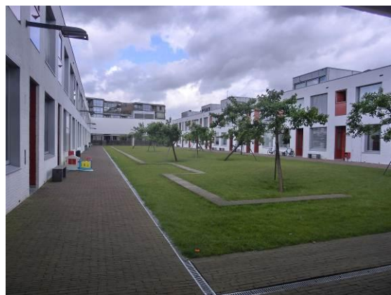
▲ Un îlot semi-ouvert autour d'un verger
